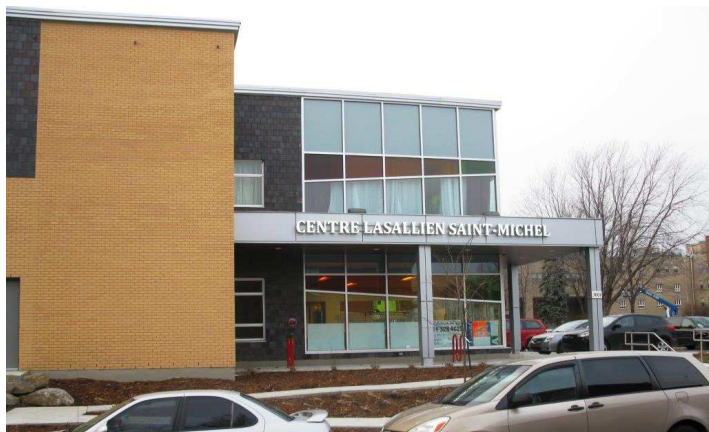
Le nouveau Centre dont le terrassement vient tout juste d'être achevé
