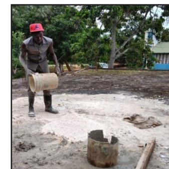
Début des travaux de maçonnerie
