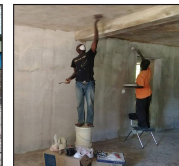
Application des peintures sur la partie déjà maçonnée
